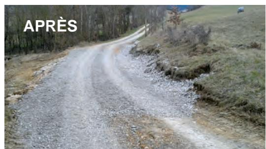
Une année 2014 très pluvieuse, un terrain argileux et très instable, des passages répétés d'engins agricoles de plus en plus lourds, et... ça glisse. Un effondrement du terrain s'était produit sur le chemin du Réjas, obligeant la fermeture du chemin durant quelques semaines. Une fois le mouvement de terrain stabilisé, des travaux ont été entrepris pour remettre le chemin à nouveau praticable. Les travaux ont été exécutés par la SOMATRA pour un montant de **2 395 €**.
